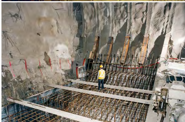
Figura 15. Arco rovescio gettato a ridosso del fronte di scavo - Galleria Raticosa ( \varnothing = 13,90 m, Terreno: argille scagliose, Copertura: 500 m) e galleria Tartaguille ( \varnothing = 15,30 m, Terreno: argille rigonfianti, Copertura max: 150 m.
