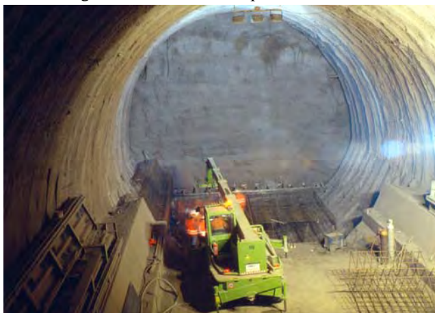
Figura 14. Allontanare il getto dell'arco rovescio dal fronte di scavo significa aumentare la superficie di estrusione
