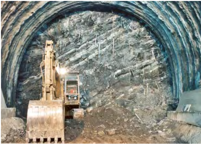
Figura 23. Galleria Monte Bibele, il nucleo-fronte rinforzato con armature di vetroresina (terreno: flysh di Monghidoro).
