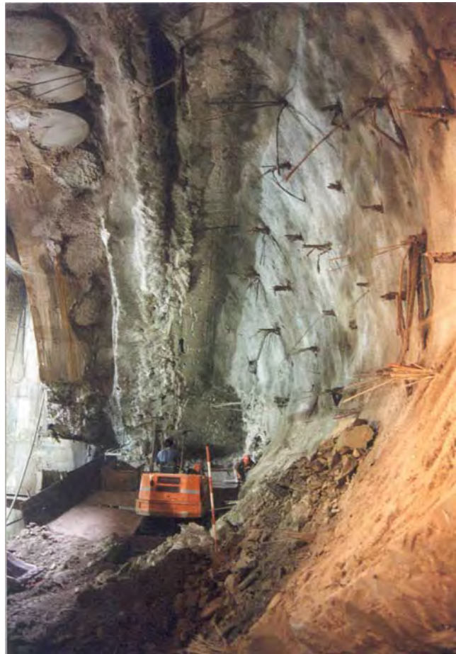
Figura 13. Fronte di scavo sagomato con andamento concavo – Galleria di stazione Baldo degli Ubaldi - ( \varnothing = 21,5 m, Terreno: argille, Copertura: 15 ÷ 18 m)
