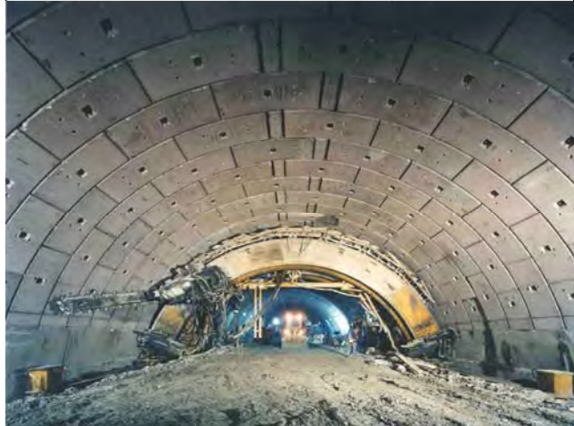
Figura 12. Pretaglio meccanico – Galleria di stazione Baldo degli Ubaldi - ( \varnothing = 21,5 m, Terreno: argille, Copertura: 15 ÷ 18 m)
