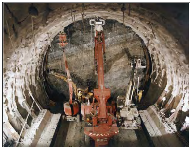
Figura 3. Galleria "Tartaignille" (Francia), ( \varnothing = 15,30 m, Terreno: argille rigonfianti, Copertura max: 150 m.
