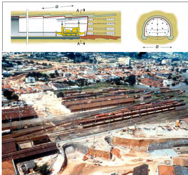
Figura 2. Protezione del nucleo-fronte con jet-grouting orizzontale a piena sezione - Sottopasso stradale dello scalo ferroviario di Campinas ( \varnothing = 14,9 m, Terreno: sabbia, Copertura 2 \div 4 m)
