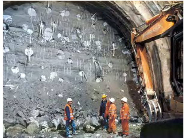
Figura 24. Galleria Firenzeuola, il nucleo fronte consolidato con micro-jet-grouting armato (terreno: sabbie argillose con intercalazioni ghiaiose).
