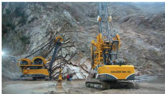
**Figura 20.** CBC 32 al lavoro come idrofresa per lo scavo dei pannelli primari in combinazione ad una MC 32 per lo scavo dei pannelli secondari con "benna intelligente" DHG
