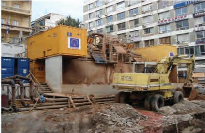
**Figura 12. Impianto di dissabbiamento, BE500 con una capacità di trattamento 500 mc/h, provvisto di centrifughe (Icotekne, Metro Tessalonica)**
