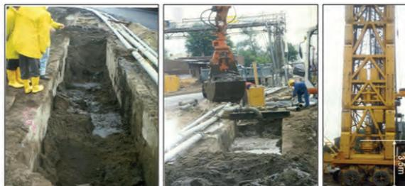
Figura 14. Realizzazione e schema tipo delle corree Fig. 15 – Prescavo mediante roto benna mordente
