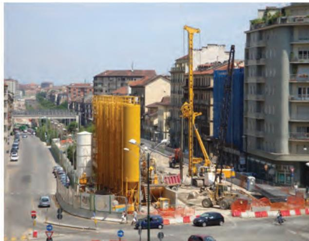
Figura 8. Sistema HSS montato su BG 40
