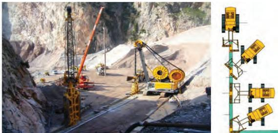
Figura 11. Possibili posizionamenti dell'idrofresa rispetto alla posizione del pannello
